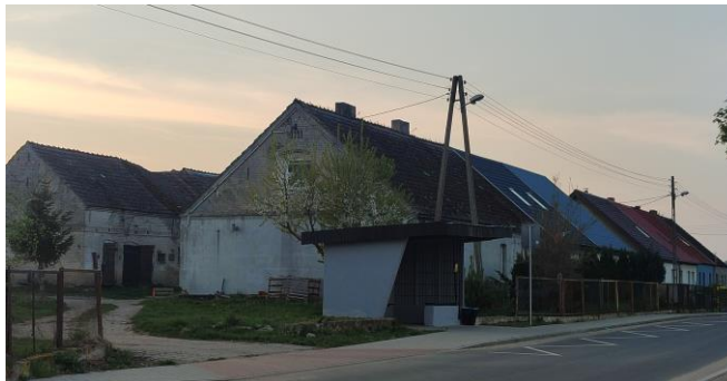
Czworaki (24, 25). Widok od południowego wschodu
