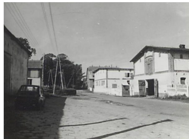
Widok na podwórze folwarczne z drogi w 1990 roku. Z lewej stodoła (16) i magazyn (15); z prawej obory (2, 3), (fot. T. Kubiak, źródło ilustracji: https://zabytek.pl/pl/obiekty/zespoldworsko-folwarczno-866581/dokumenty/PL.1.9.ZIPOZ.NID_N_32_EN.452582/11 )
